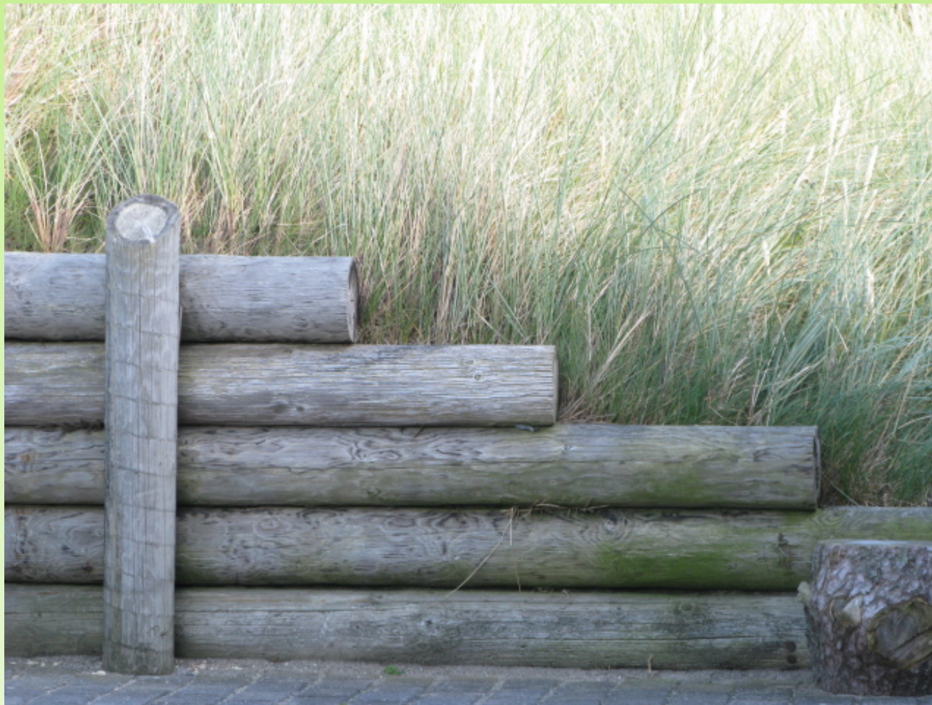
Støttemur i ubehandlet rundtømmer er diskret i både form og farve
