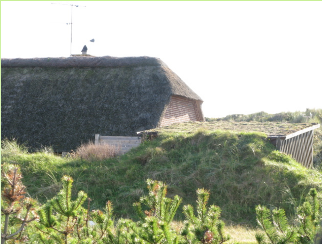
Udhus med naturgræs på taget og bygget ind i volden ses næsten ikke i landskabet
