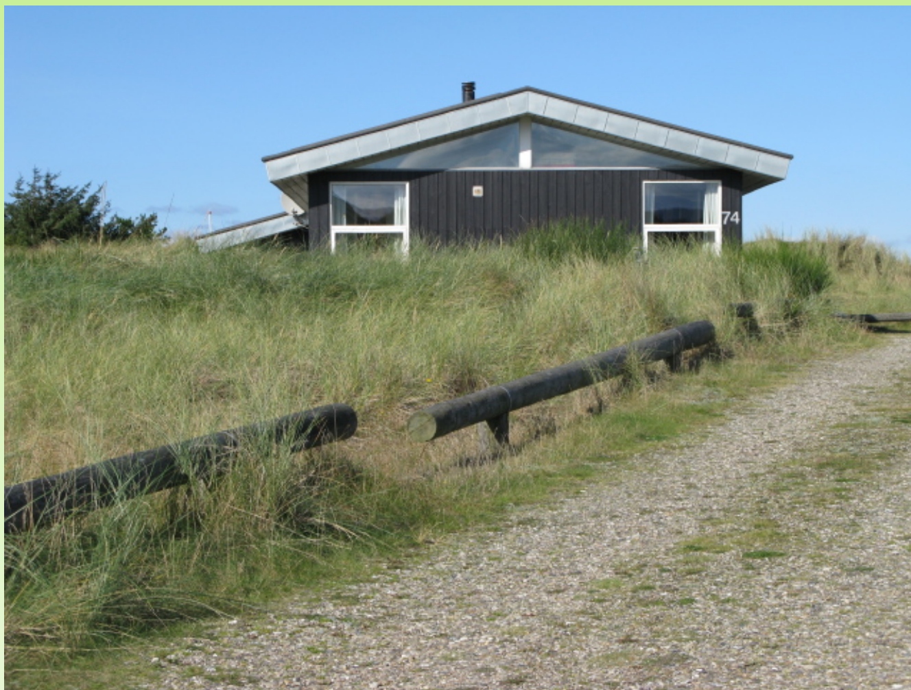
Acceptabel markering af vej med horisontalt rundtømmer
