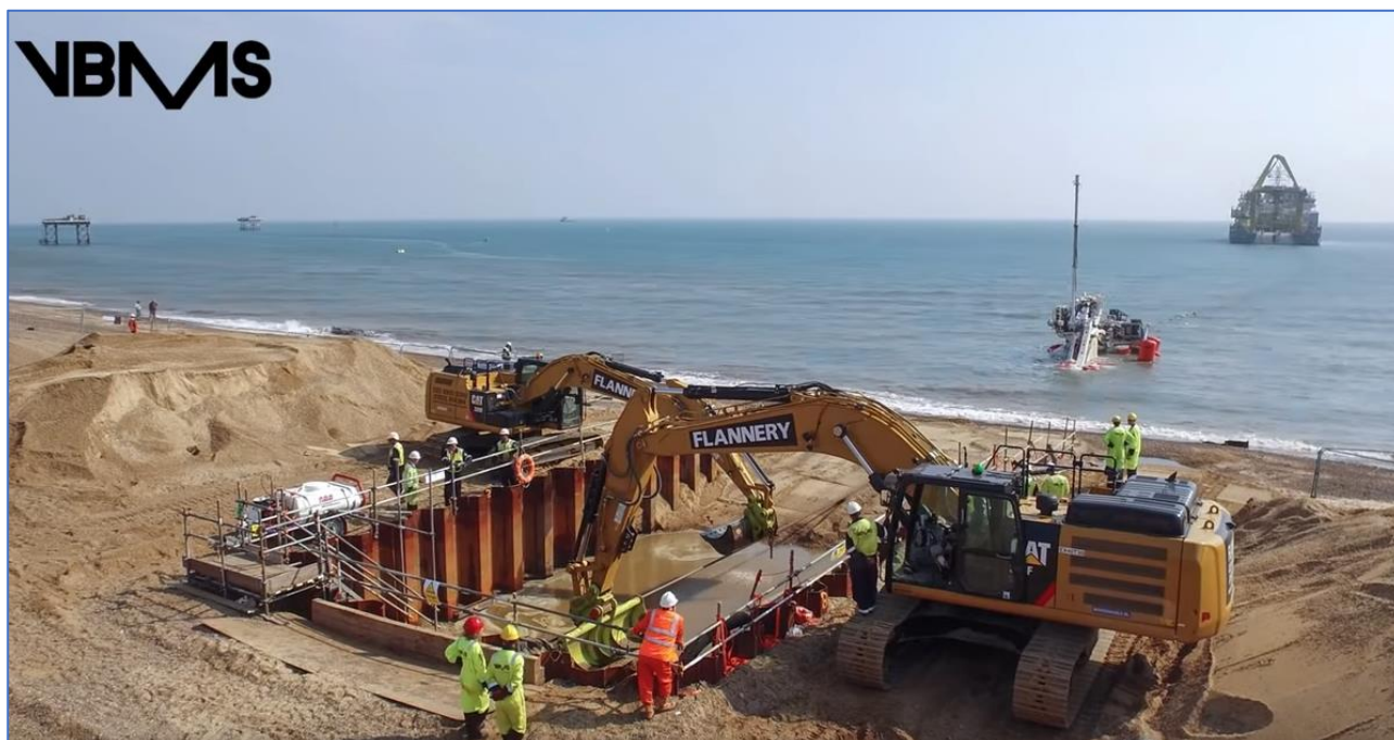
Figur 2: Eksempel på hvordan arbejdsområdet på stranden vil se ud den dag kablet skal landes. Ploven der skal nedgrave, kablet i 4 meters dybde ses i vandkanten. Kabelskibet ligger ca. 600m fra kysten
